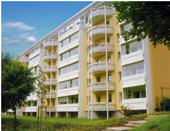
Gut für Mieter und Vermieter: Die Wohnungsbau Wohnungsverwaltung Weißenfels GmbH spart mittels Gebäudeautomatisierung 30 Prozent der Heizkosten ein.
