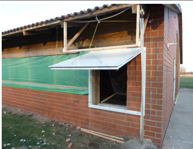
Westwand des Putenstalls umgebaut mit Einlass für Luft in den Wärmetauscher
