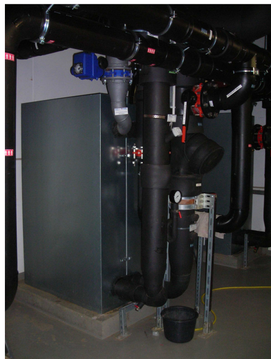
Plattenwärmetauscher
