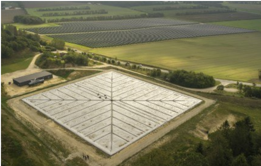
Abbildung 3: Solarthermiefeld und Saisonspeicher in Dronninglund
