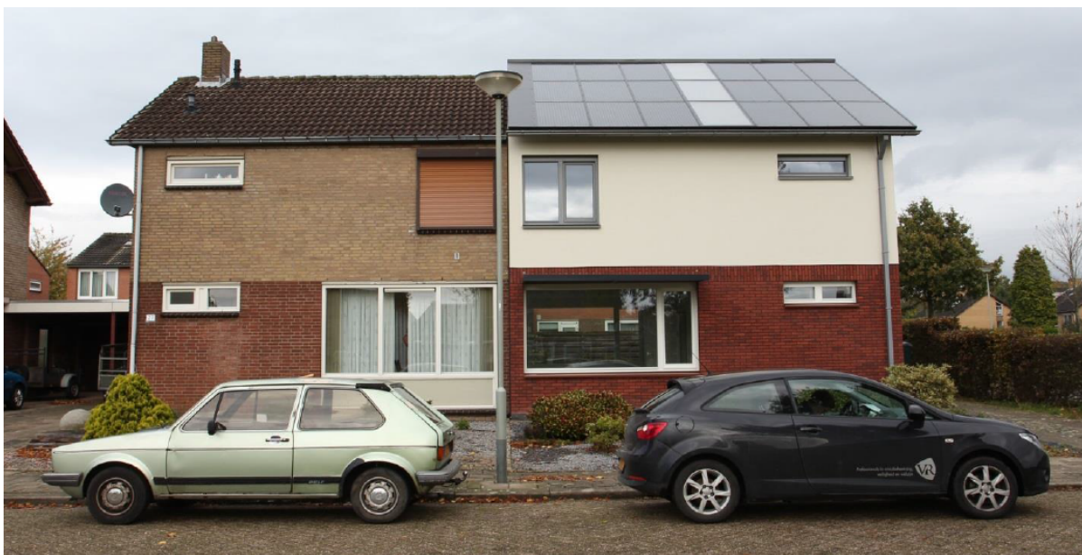
Abbildung 9: Unsanierete und seriell sanierte Doppelhaushälfte
