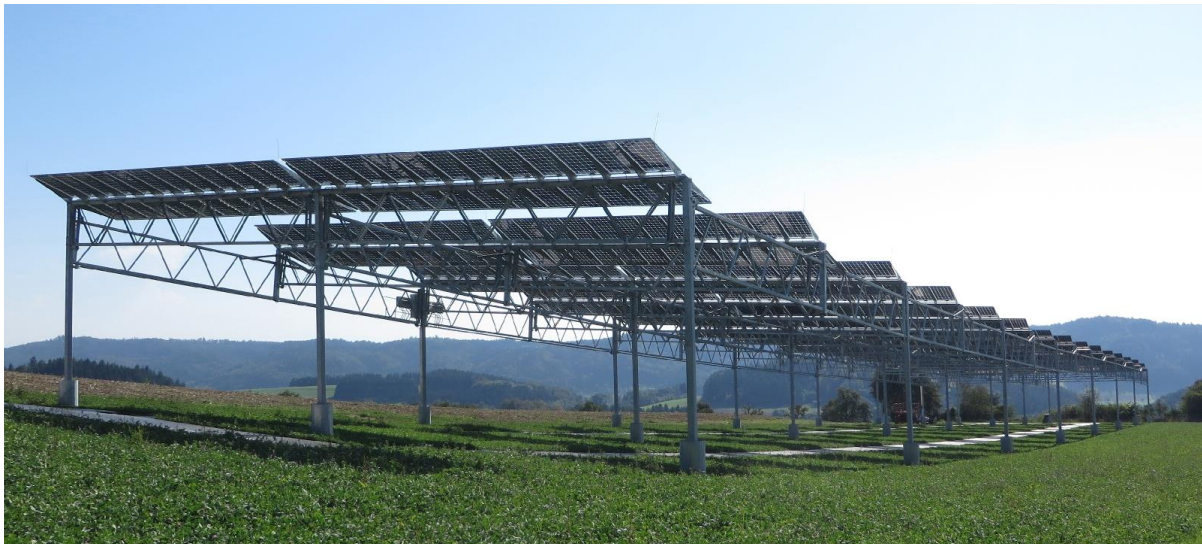
Abbildung 2: Agrophotovoltaik-Pilotanlage in Heggelbach am Bodensee
