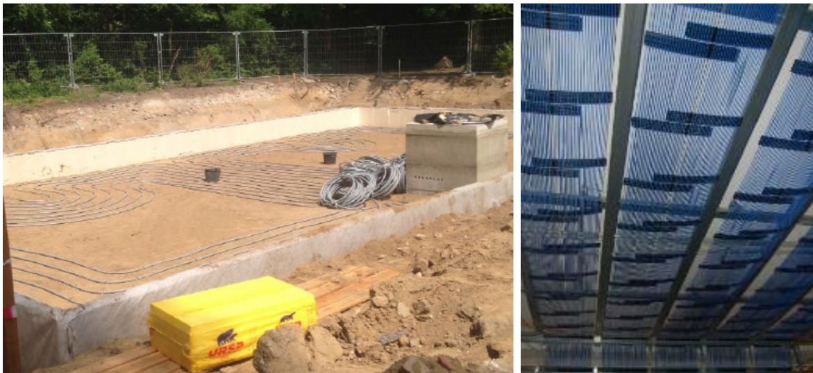
Abbildung 14: Niedertemperatur-Erdwärmekollektor und Speicher und Deckenstrahlungsheizung
