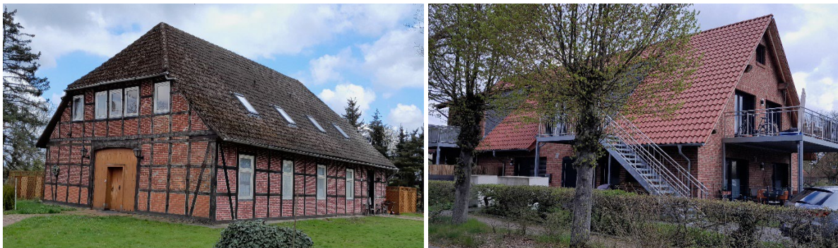
Abbildung 19: Verschiedene ehemalige Hofstellen unsaniert (links) und saniert (rechts)
