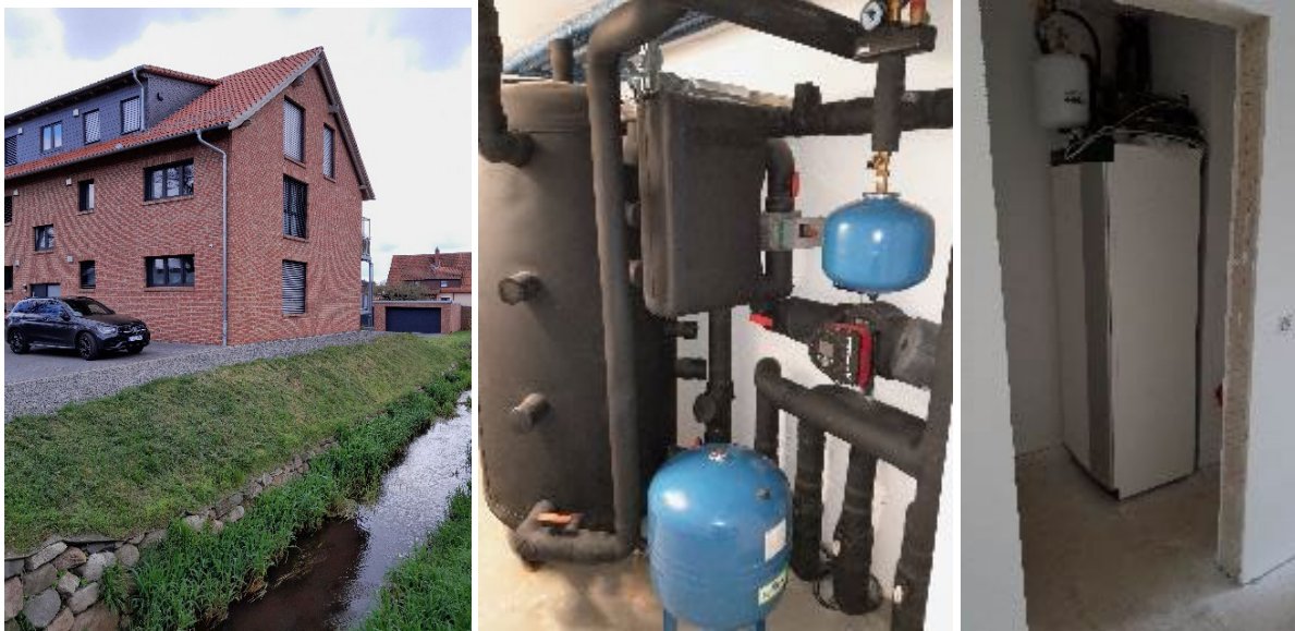
Abbildung 20: Saniertes Mehrfamilienhaus im Wasserschutzgebiet
